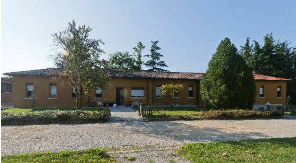
L'edificio 11, vista del prospetto nord-ovest
